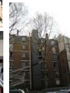
Installations sur des arbres d'alignement - DEV - Paris (75)
